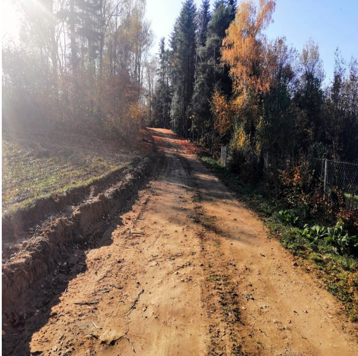
Droga po remoncie:
